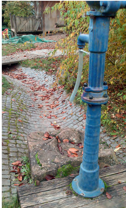
Aus einer Zisterne wird über eine Schwengelpumpe ein Becken gefüllt, ein Wasserlauf gespeist oder Gießwasser abgefüllt.
